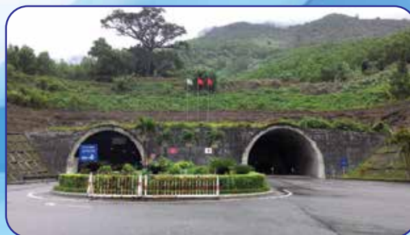
Mở rộng hầm đường bộ Hải Vân (L=6,2km) Road tunnel widening of Hai Van pass (L=6,2km)
