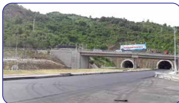
Hầm đường bộ Cổ Mã (L=500m) Road tunnel of Co Ma pass (L=500m)
