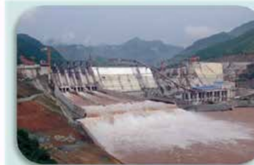
Dự án thủy điện Sơn La (CP Việt Nam)
